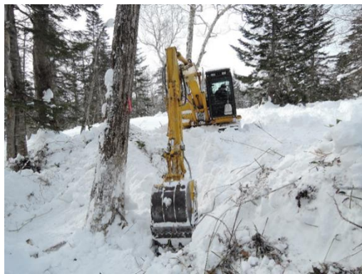
図-1 通常の根掘り
