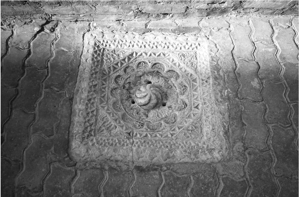
写真5 シェール・ガーズィー・ハン・マドラサ玄関前の排水孔付き敷石 (トッシ)
