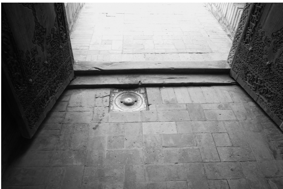
写真4 パフラヴァーン・マフムード廟入口の排水孔付き敷石（トッシ）
