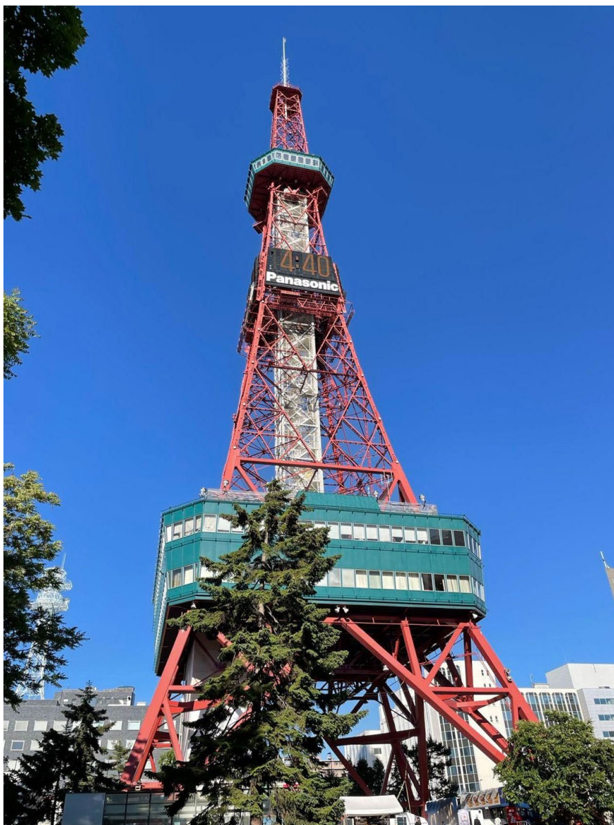
札幌电视塔 笔者拍摄于2022年6月12日 2
