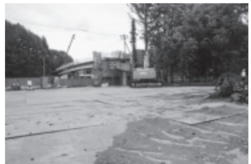
H. 北海道大学基幹・環境整備（跨道橋撤去等） 工事（北西より）調査番号：2123
