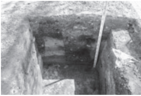
A. 構内（北13条道路等（歯学部））外灯改修工事 TP 01（北より）調査番号：2102
