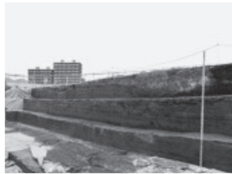
B. 北壁の様子（セクション：南東より）
