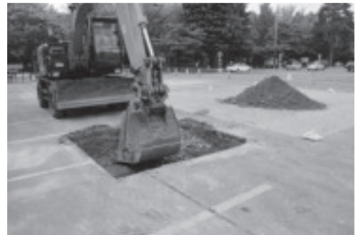
D. 調査の様子 (TP 06: 北東より)
