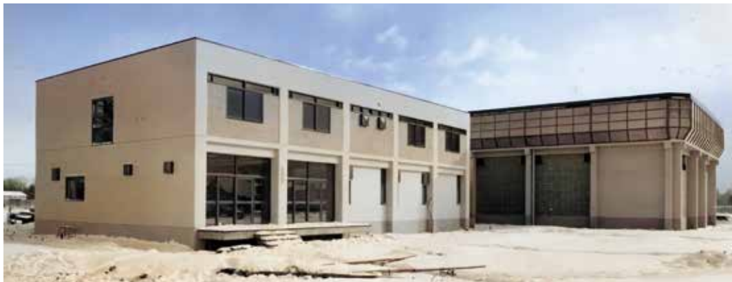
写真1 北海道大学スポーツトレーニングセンター（竣工写真）
