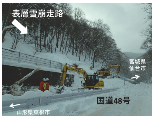
図 3-34 宮城県仙台市関山峠で発生し国道 48 号に達した事例 No. 7 の表層雪崩（Nakamura, 2022 に加筆） * 図 3-33 の事例 No. 7 の表層雪崩。
