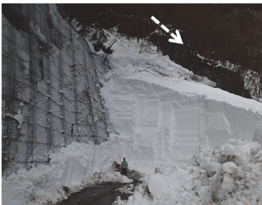
図 3-10 表層雪崩で埋没した県道 36 号（中村ら，2014）
