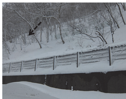
図 3-19 落石防護柵をすり抜けて国道 48 号に達した表層雪崩（中村ら, 2014）
