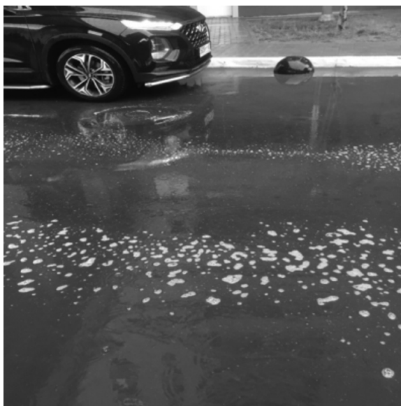
図1 降雨直後の走行車両のタイヤ付近に発生したアスファルト舗装表面の黒い水と大量の白い泡とその泡の中の細かい黒い物質
