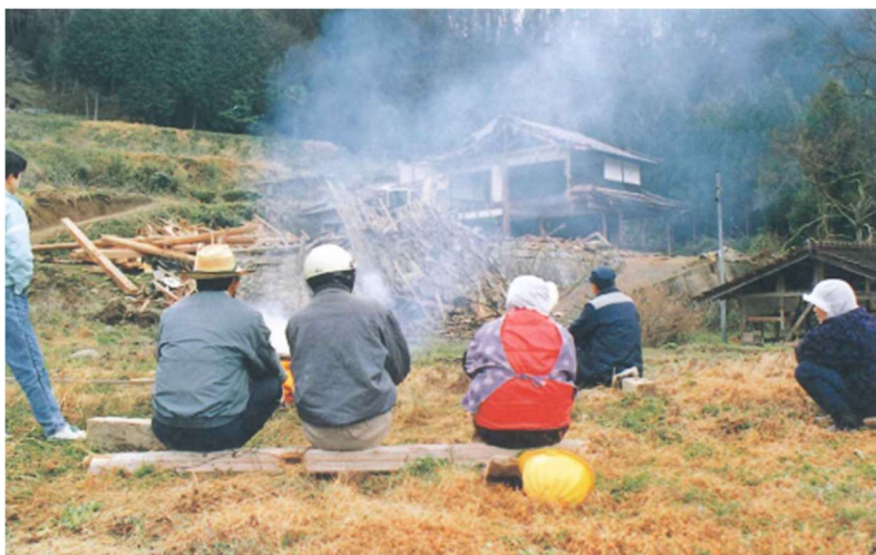
写真 30 取り壊し作業の様子（苫田ダム記念誌編纂委員会, 1997）
