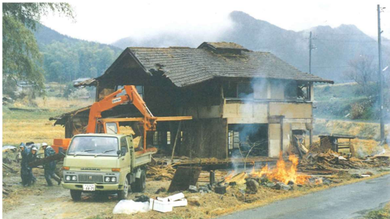
写真 29 取り壊し作業の様子（苫田ダム記念誌編纂委員会, 1997）
