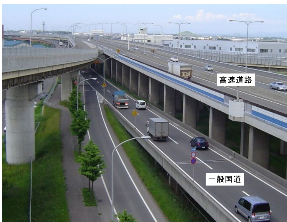
図 1.10 札幌自動車道の橋梁高架区間
