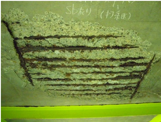
(e) 鋼橋 RC 床版
