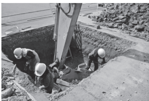
A. 調査の様子 (TP 01 : 北東より)
