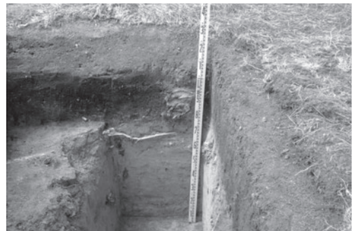
F. ワイン研修センター改修室外機基礎その他敷設工事 TP 04（南より）調査番号：2205
