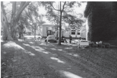
G. ワイン研修センター改修室外機基礎その他敷設工事（北より）調査番号：2205
