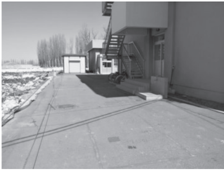
A. 確認調査前の状況（遠景：南より）
