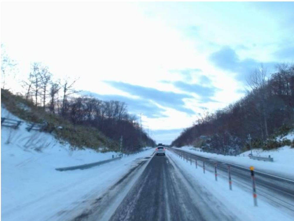
(b) 路面状態が「slush」と推定された画像の例
