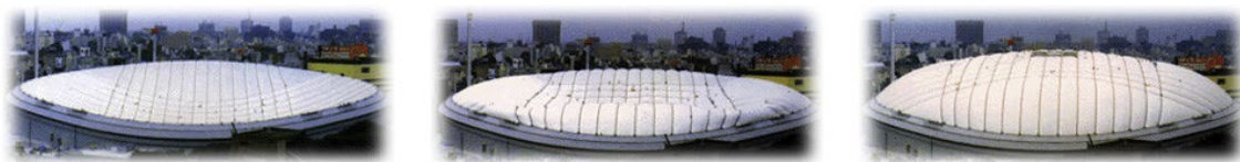
図-4.3.3 東京ドームの屋根（写真左から右にかけて、空気を送り込んでいる） [31]
