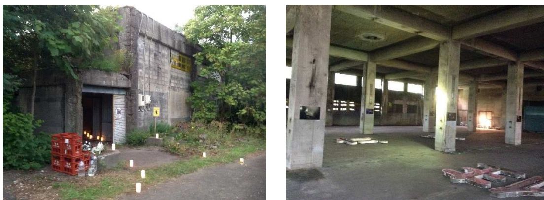
図 5-3 赤平市の「坑口浴場」(左：外観 右：内部のかつての脱衣所) いずれも「そらち炭鉱の記憶アートプロジェクト」開催時のもの [出典]筆者撮影 (2017年9月17日)
