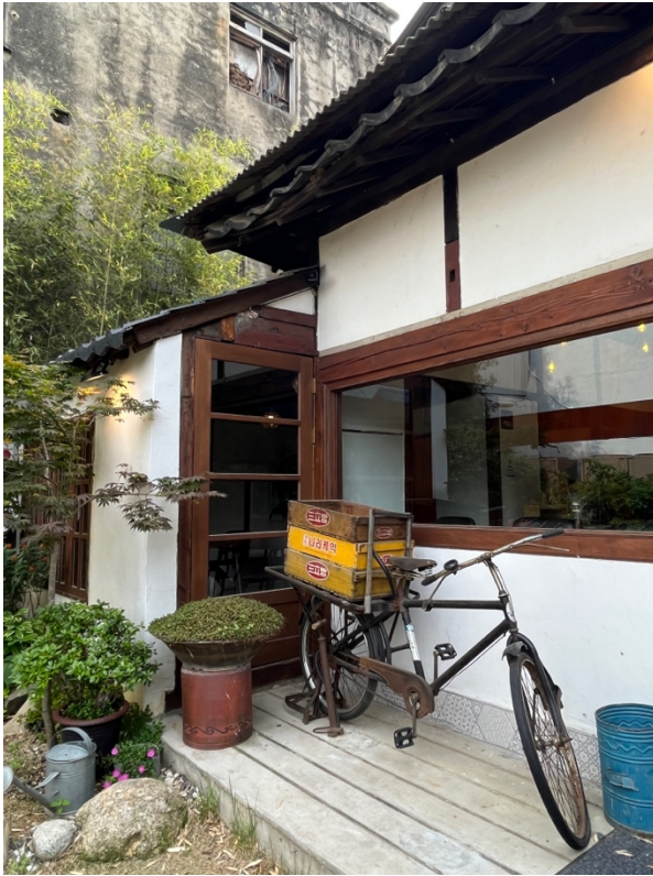
図 4-8 建物Fにおける植民地期の建物3棟の中の1棟（筆者撮影 2022年5月11日）
