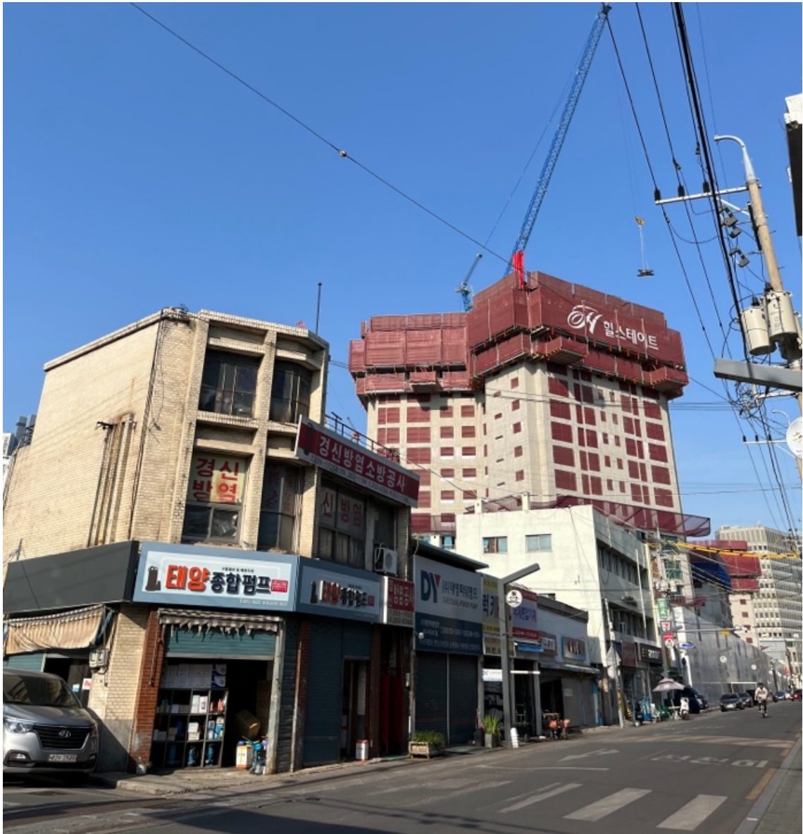
図 3-8 北城路の工具商店街の都心再開発により、大手建設会社のマンションが建てられている。（筆者撮影 2022 年 4 月 20 日）
