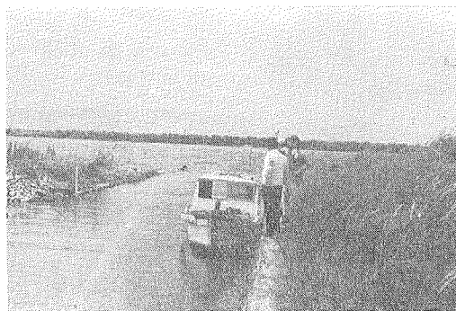
図-2 北生振揚水場取水口
