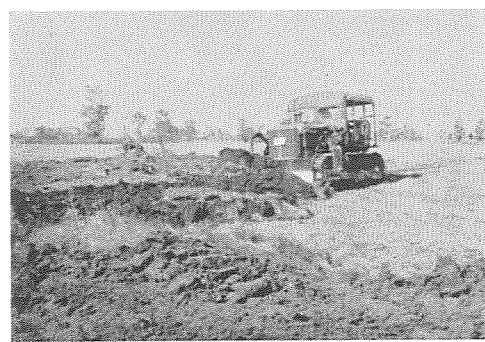
18. ブルドーザーでの基盤整備 (図-5の11圃場で) 昭和37年11月
