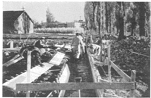
写真5. 承水路コンクリート打ち
