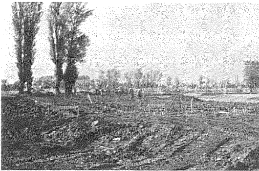
写真2. ブルドーザーによる盛土
