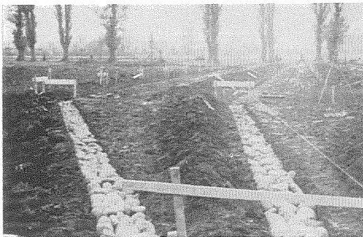
写真3. 導流堤栗石基礎
