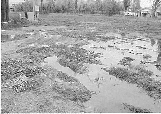
図5. 消化液タンク周辺の状態
