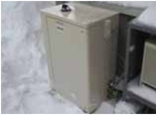
ガスエンジン発電ユニット
