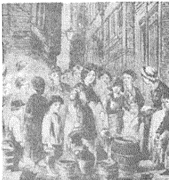
共同水道栓 〔図III-5〕
