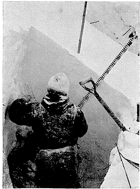
図1 断面観測のため積雪に穴を掘ったところ
