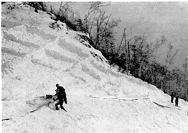
第1図 恵庭岳滑降コースの中程につくられた雪を溜める雪堤の柵 (札幌オリンピック支援集団提供)
