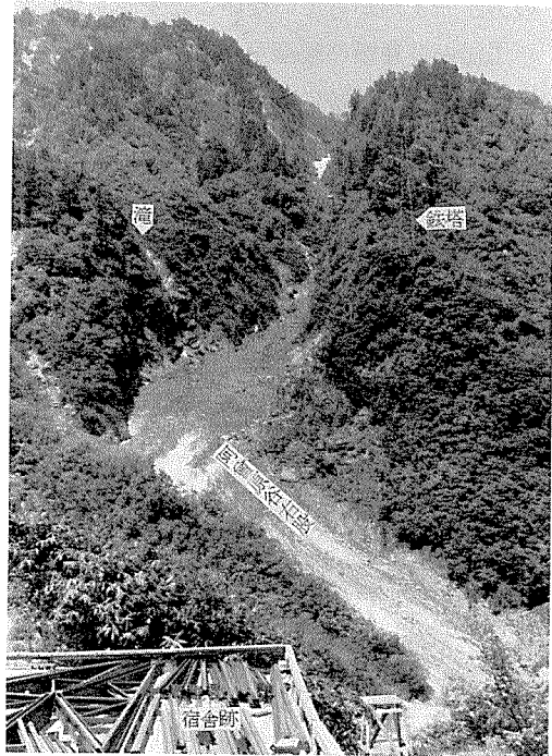
第11図 阿曾原谷右股と宿舎跡。圧痕計設置場所は、写真上で鉄塔のやや左下の裏側にあたる。谷は厚さ約 40 m の残雪とデブリに埋められている。(昭和 48 年 5 月撮影)
