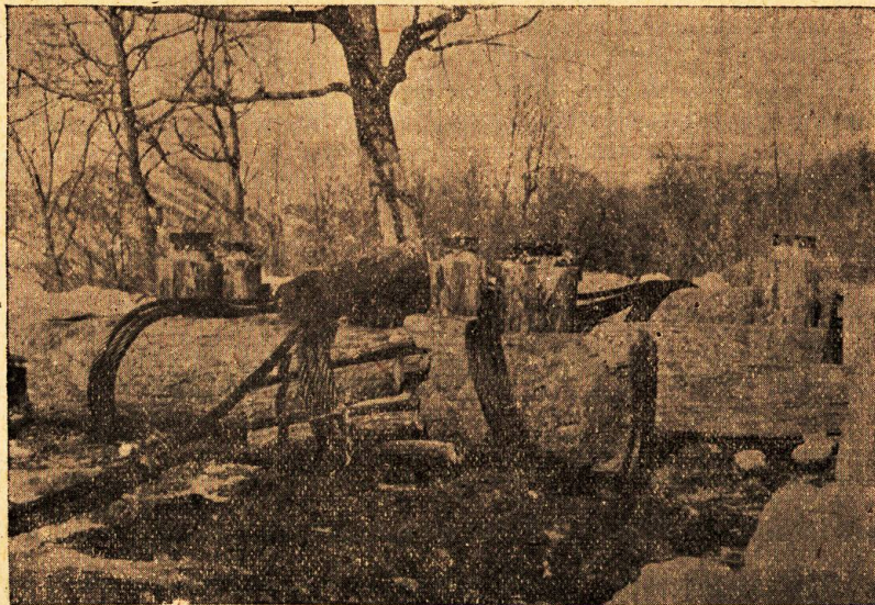
圖-50. 木杭群による上親杭(表親綱のもの)
