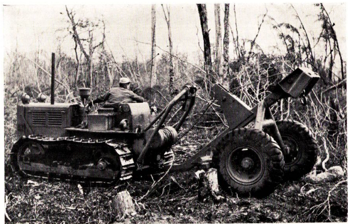
第1図 供試トラクター及びロンギングアーチ
