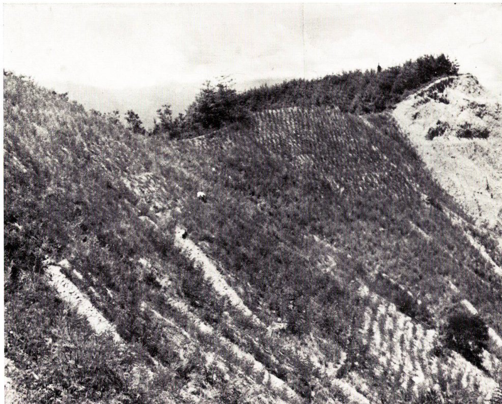
写真8 長野県東筑摩郡明科町大字七貴 地質洪積層 むしろ張工 (1954) 施行後3カ月経過 (犀川治山事務所)
