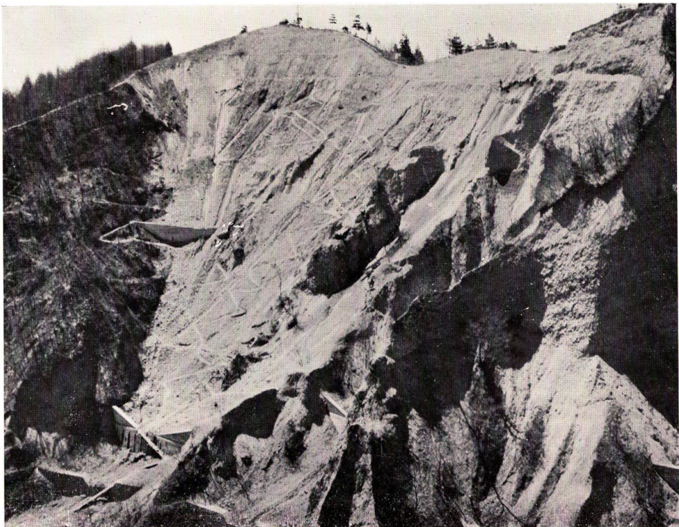
写真2 施行前の状況 (法切り作業後)
