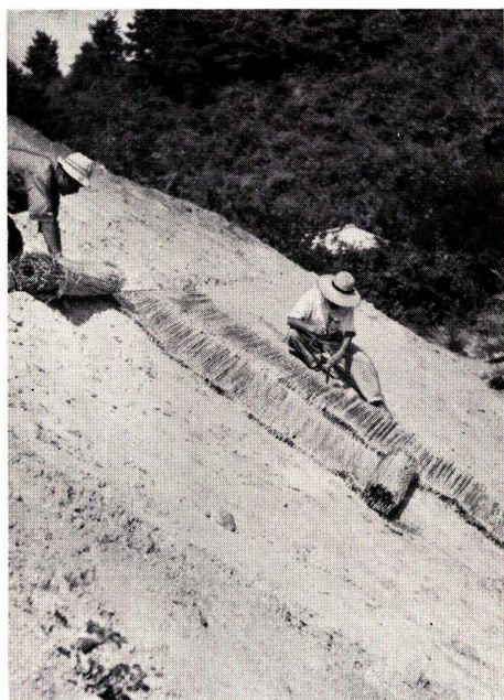
写真5 長野県東筑摩郡明科町大字七貴大峯 むしろ張工 (2) (施行) 1956 施行中 (犀川治山事務所)
