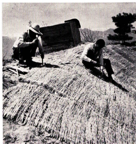
写真6 むしろ施設作業
