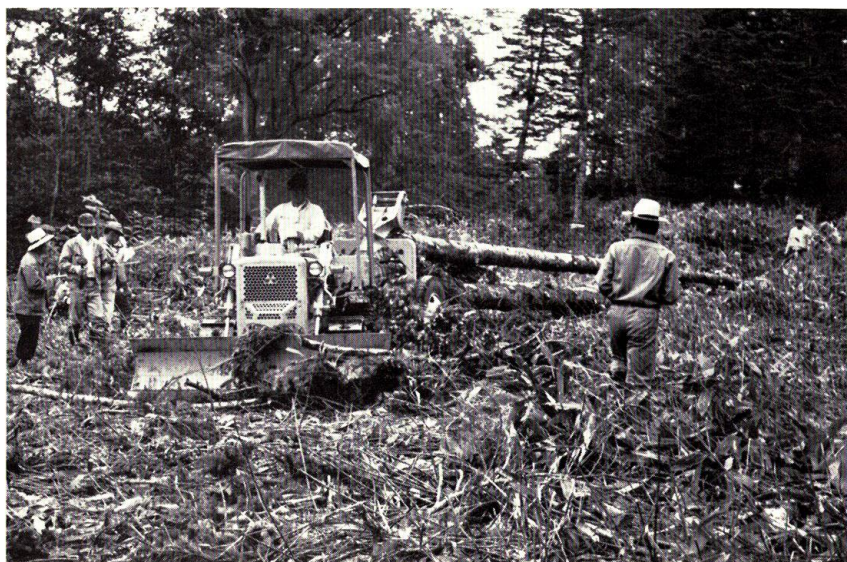
写真 9. 下山障害物排除 (BD 2 型トラクター)
