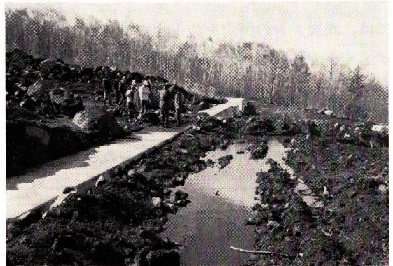
図-63. 床固工の袖部天端にうず高くのりあげた土石流の痕跡を示す岩塊群(羊蹄山)
