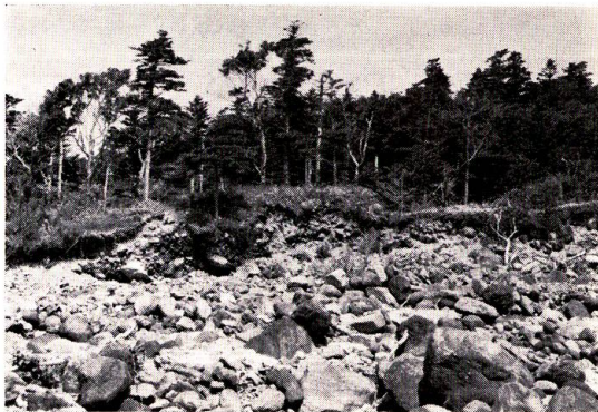
図-9. 扇状部の現流路とその右岸の欠壊状況
