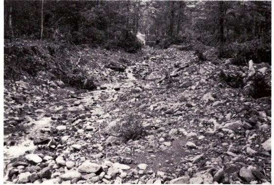
図-29. 砂防ダム設置後の扇状部洗掘状況
