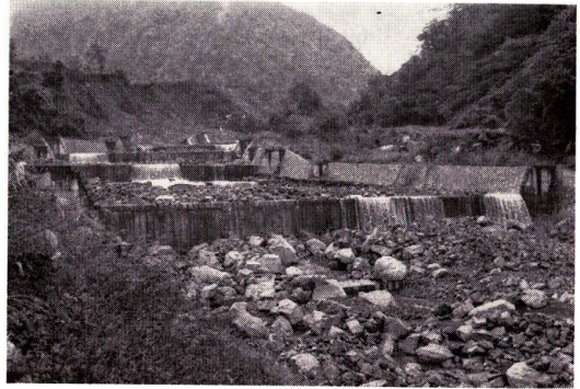
図-45. 堆積地における流路工の効果
