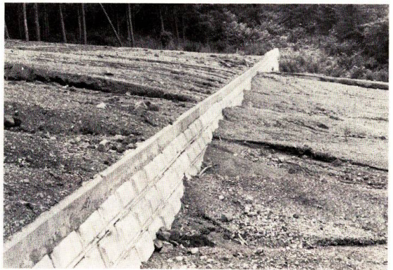
図-62. 扇頂部の土石分散ダムの効果 (大有珠南麓)
