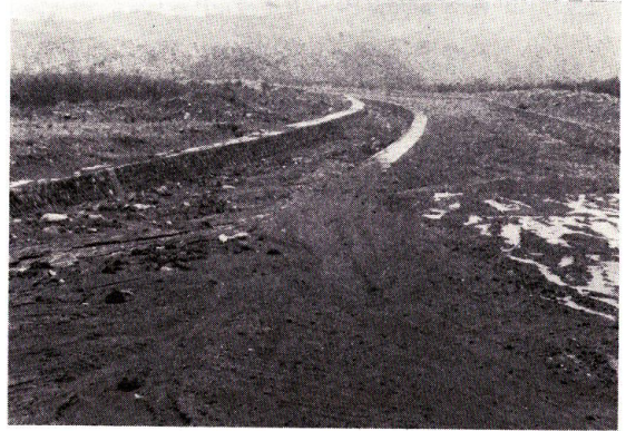
図-42. 扇状地内の流路は、護岸工のみでは固定することができない
