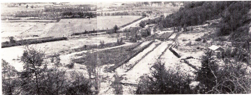
図-47. 昭和新山南山麓のガリー氾らん原の分散処理工法(土のいおよび編さく工)
