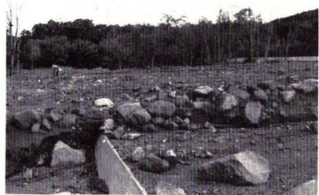
写真一5 扇状地の古い広葉樹群落とダム天端による退き水の洗掘防止効果 (青木の沢)
