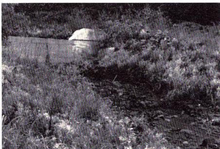
写真一3 泥らん原の流路に設置されている床固工 (雪崩の沢)
