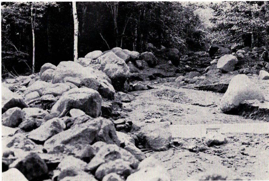
写真一8 床固工群による流路方向の固定 (青木の沢扇状地, 1975)
