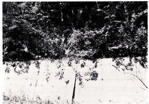
写真-13 基礎工と被覆率 (道東林道 plot No. 4)
