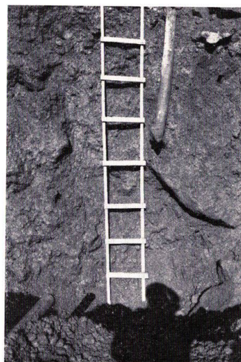
写真-7 掘削断面(スリット上流5m)
