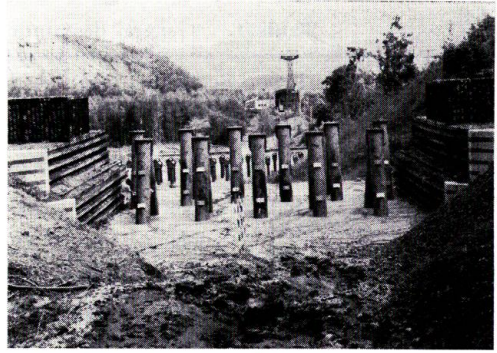
写真-1 2号スリットダム(鋼製A型), 下流は1号スリットダム(鋼製門柱型)
