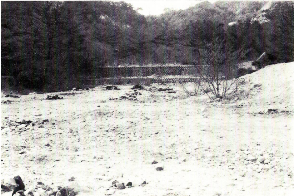
写真—11 同逆瀬川 (図-34) 中流部における溪床固定横工群。
