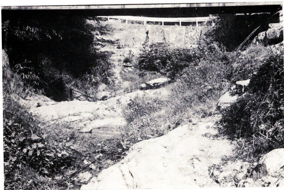
写真—10 同宇治川再度谷における再度谷堰堤 (図-36, ダム No. 3) 下流の岩盤露出状況。
