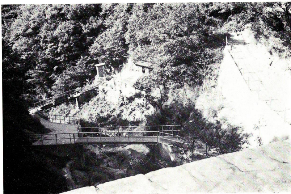
写真—9 六甲山系西郷川青谷における亀の滝堰堤 (図-35, ダム No. 2) 下流の岩盤露出状況。
