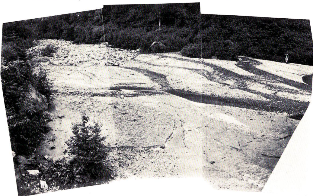
写真-6 砂防ダム堆砂状況 (D-4, 施工後9年) 堆砂面の区分が認められる
