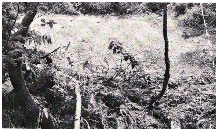
写真一22 1984年無処理区に発生した崩壊地（表層剥落型）の状態
