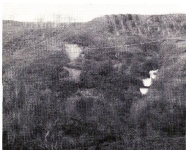
写真一21 1981，1984年無処理区に発生した崩壊地
