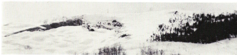
写真一19 同1981年大雪による雪崩発生の状態（右雪崩防止工施工，左無処理）
