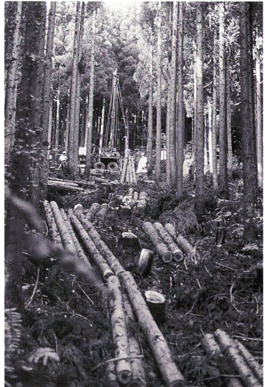
写真－1 伐間幅の広いケース 先柱側からタワーヤード方面をみた状況。
