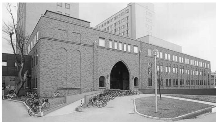
写真3 二号館玄関 (北海道大学事務局施設部所蔵)
