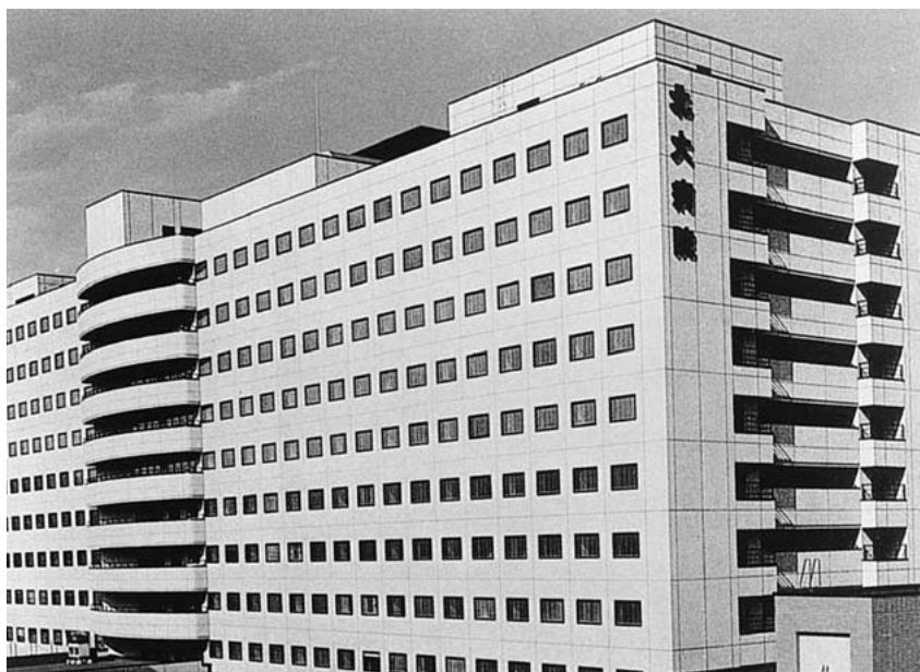
写真10 附属病院新病棟の完成 (1994年)
