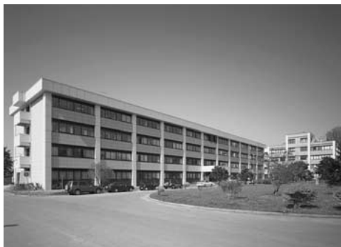
写真1 大学院獣医学研究科・獣医学部研究棟 (左手:本館、右手奥:S棟)
