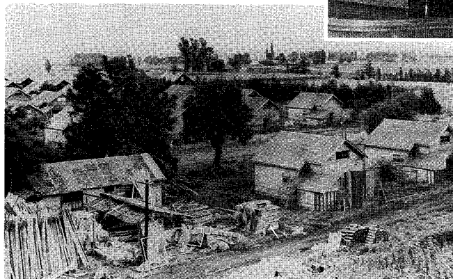
建築中の大学村10万円住宅(1950年)
