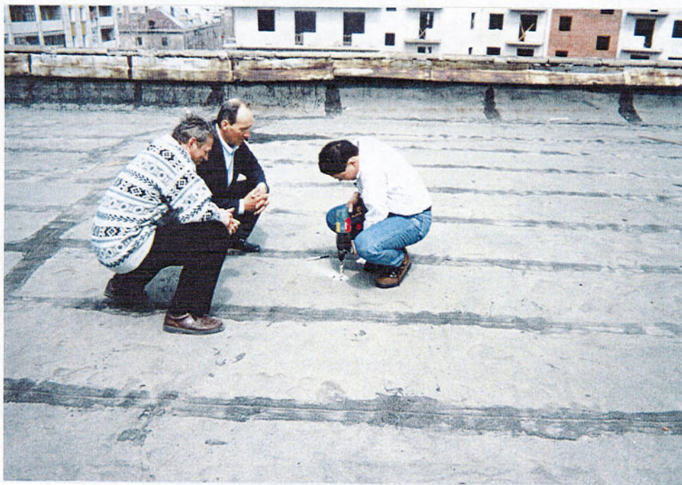
図 2—2—4 Khabarovsk でのアンテナ設置。鉄筋コンクリートの建物の屋上に、ドリルで穴を開けてボルトを埋設し、アンテナを固定した。
