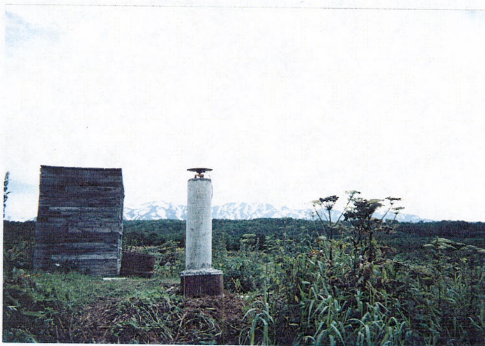
図 2—2—5 Kortberg でのアンテナ設置状況。ピラーを建設してその頂部にアンテナを設置した。
