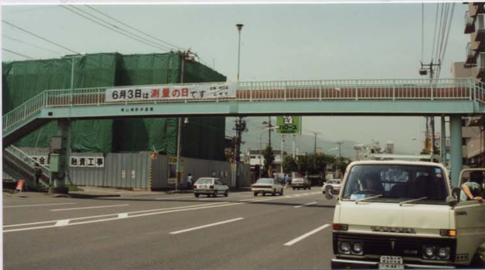
写真-5.7 東山歩道橋
