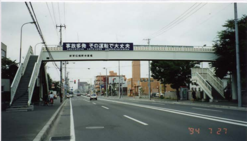
写真-5.8 新琴似歩道橋
