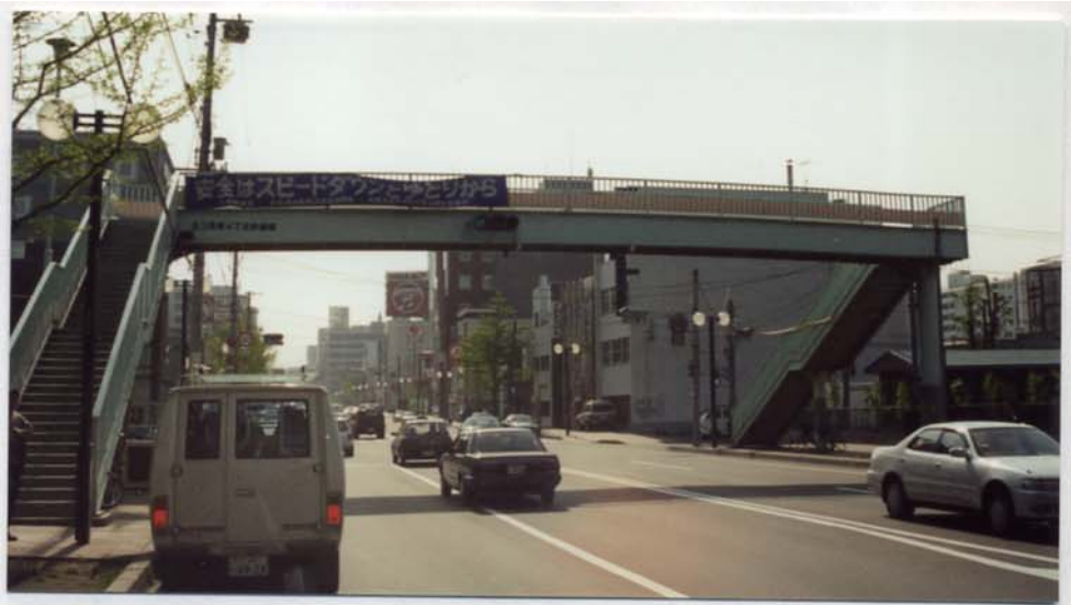
写真-5.4 北3条東4丁目歩道橋
