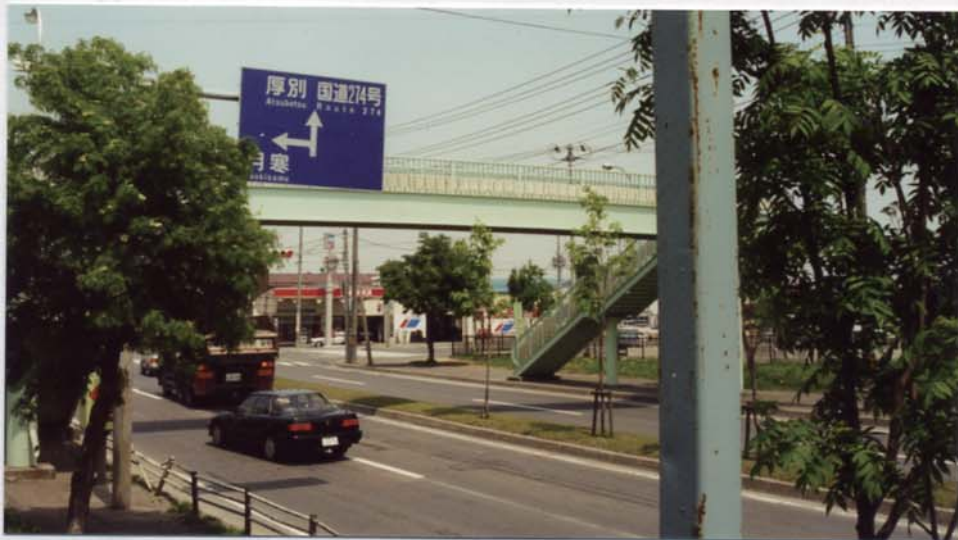
写真-5.5 平岡歩道橋
