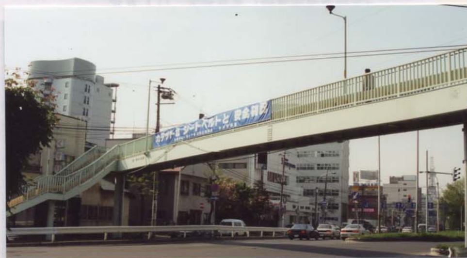
写真-5.9 豊水歩道橋
