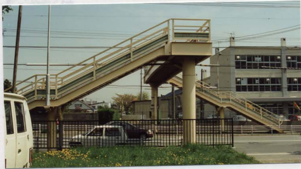
写真-5.1 山の手小学校前歩道橋
