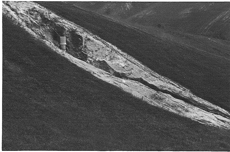
写真-Ⅲ・5 パイプラインの漏水に起因するカリ (東谷地区, 1979. 9. 1)
