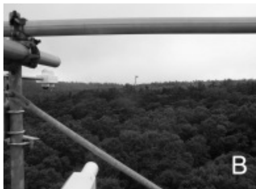
図 3.5 高所作業車を用いたシンチロメータ計測の様子。(A)ターンテーブルにトランスミッタを固定 (手前は、遠隔操作用のコントローラ) および(B) Tower-1 に設置したレシーバから望むトランスミッタ。
