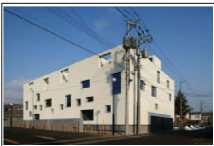
図6 圧迫感を緩和する外観
