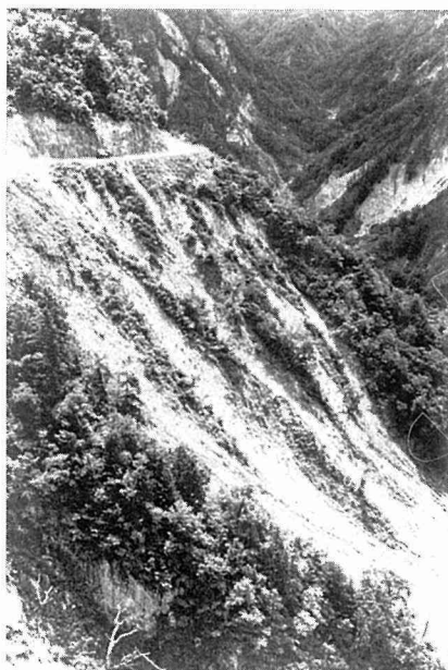
Photo 1. 白山スーパー林道。急斜面では大規模な崩落が見られる。(1982年6月19日撮影)
