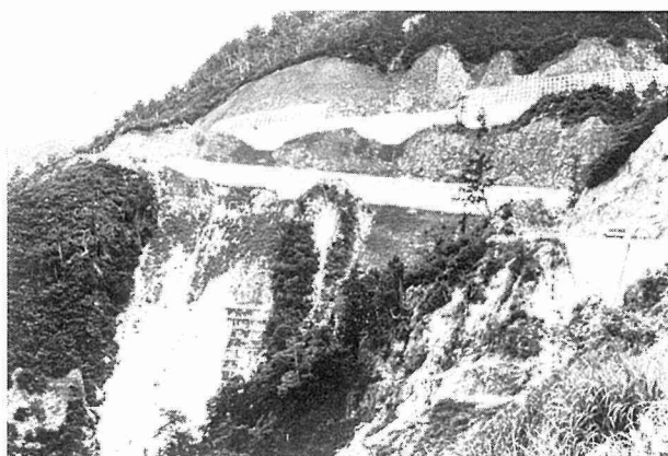
Photo 2. 白山スーパー林道。崩落はヘアピン・カーブやトンネル出入口付近で著しい。(1982年6月19日撮影)
