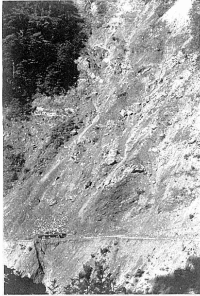
Photo 4. 日高横断道予定地の林道。至る所で法面の崩落が見られる。(1982年7月4日撮影)
