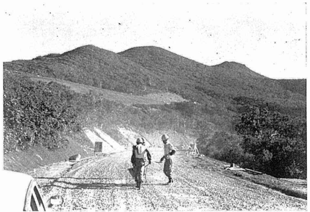
Photo 5. 知床横断道路。未舗装のまま開通した所では砂塵による影響が心配される。
