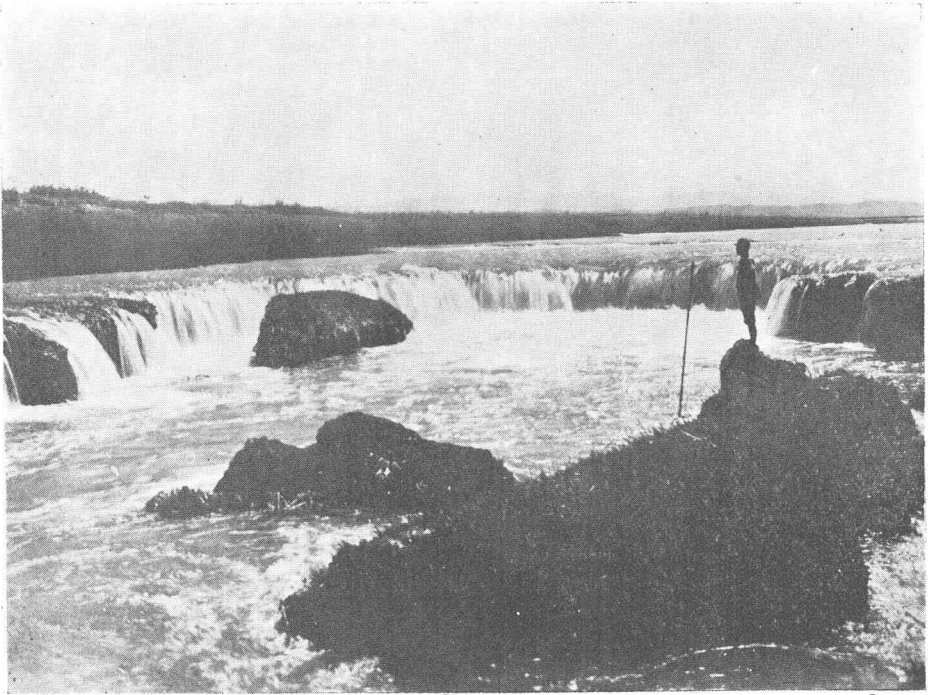
Abb. 34. Der Absturz von 4 m Höhe des neuen Wasserlaufes des Yubari-Flusses am 12. Juni 1937.
