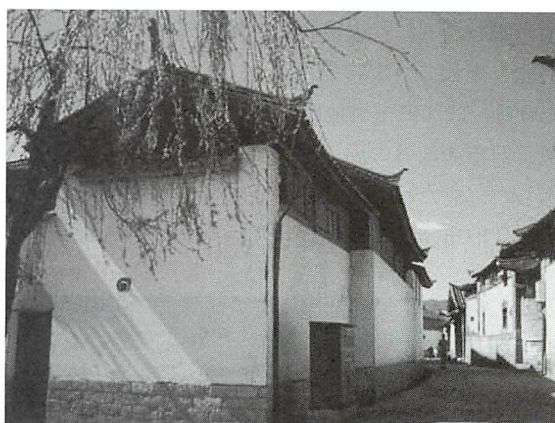
fig-3-2 日干しレンガの上に漆喰仕上げの住居
