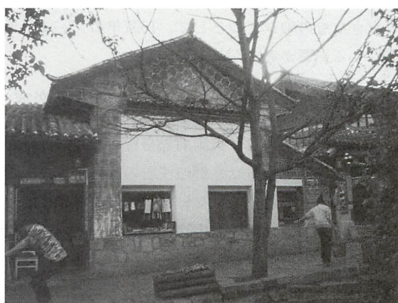
fig-12 開口が差し込まれた妻側の壁面
