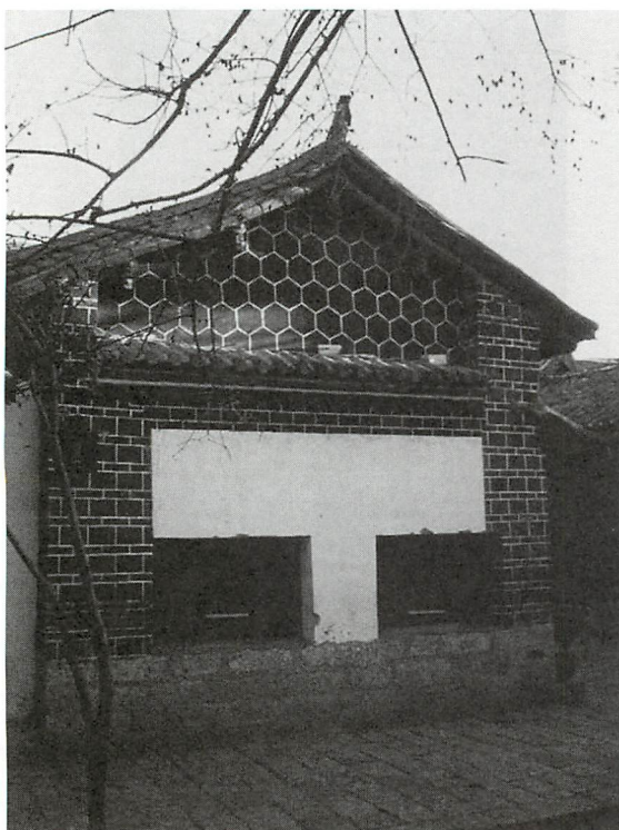
fig-7 ペンキにより描写されたレンガ目地
