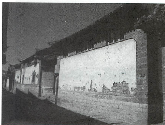
fig-3-3 日干しレンガの上に漆喰+四隅にレンガ仕上げの住居
