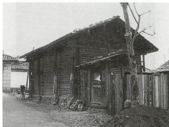
fig-9 農村部に見られる校倉造り様の建築物
