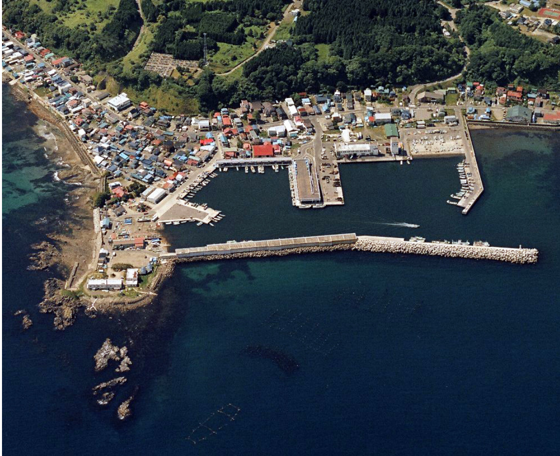
図 1-1. 白尻水産実験所と白尻漁港 (平成 19 年 7 月 25 日 函館開発建設部撮影)。
